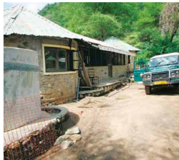
Das Douglas and Ian Hamilton Forschungscamp im Lake Manyara National Park, Tansania, wurde kürzlich reaktiviert und für Forschungsarbeiten renoviert. Foto: Knauf
